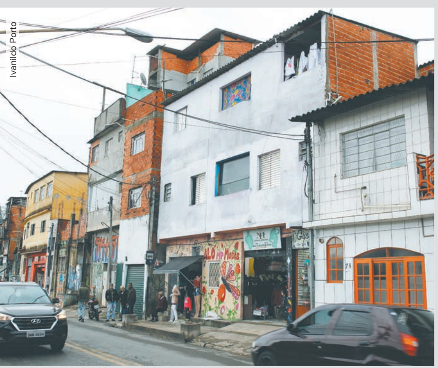
Defesa Civil de Guarulhos interdita residência atingida por deslizamento na região da Vila Galvão após chuvas GH Pág. 4
